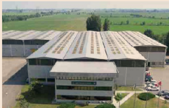
Esterno dello stabilimento
